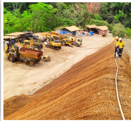
Hydroseeding Area Bekas Tambang Pulau Wetar, Maluku Barat Daya
