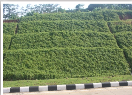
Hydroseeding Kawasan Industri KIT Batang, Jawa Tengah
