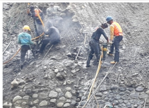
Boring untuk Soil Nailing, Waduk Cacaban, Tegal
