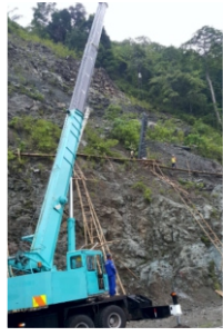
Pemasangan Rock Barrier, Ende, NTT
