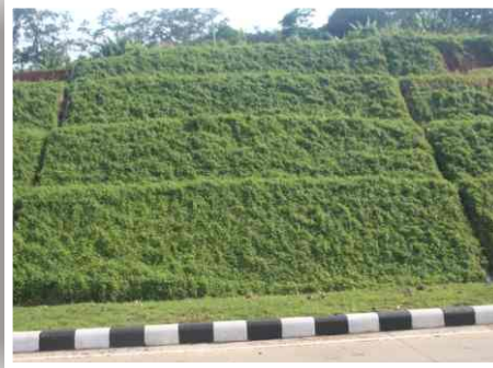
Hydroseeding Kawasan Industri KIT Batang, Jawa Tengah
