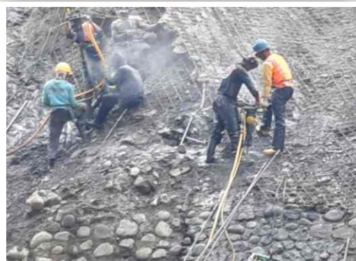
Boring untuk Soil Nailing, Waduk Cacaban, Tegal
