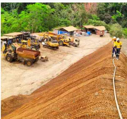
Hydroseeding Area Bekas Tambang Pulau Wetar, Maluku Barat Daya
