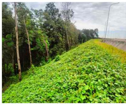
Hydroseeding Kawasan Industri KIT Batang, Jawa Tengah
